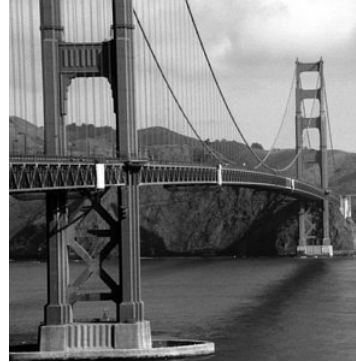
Estructura Flexible Periodo Largo Frecuencia Baja
