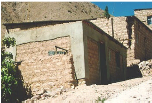
Figura 5. Viviendas existentes reforzadas en 1998 en Moquegua, después del sismo del 2001. Las viviendas vecinas con fuertes daños carecían de refuerzo.
