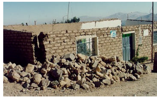
Figura 6. Colapso total y daños severos producidos por el sismo del 2001 en las viviendas de adobe carentes de refuerzo en Moquegua.
