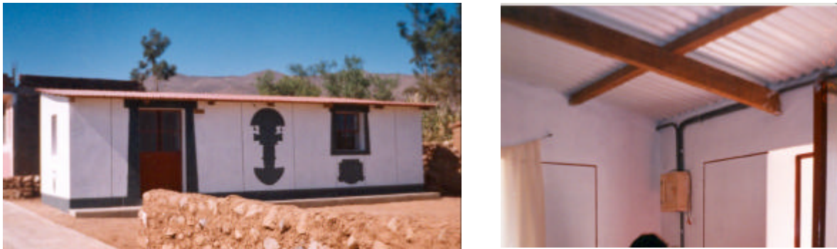
Figura 11. Vivienda construida por el Convenio PNUD-SENCICO.
