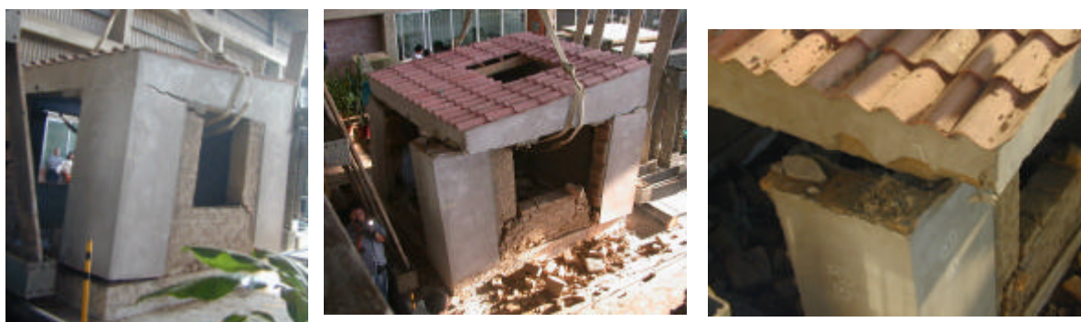
Figura 10. Comportamiento del módulo durante el movimiento sísmico catastrófico (izquierda), después del ensayo (centro) y rotura del diente de concreto (derecha).
