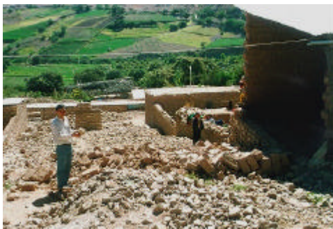
Figura 6. Colapso total y daños severos producidos por el sismo del 2001 en las viviendas de adobe carentes de refuerzo en Moquegua.
