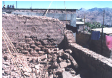
Figura 5. Viviendas existentes reforzadas en 1998 en Moquegua, después del sismo del 2001. Las viviendas vecinas con fuertes daños carecían de refuerzo.
