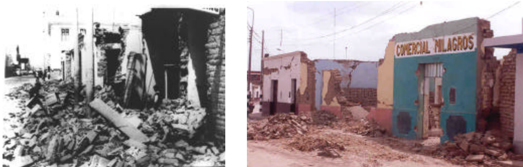
Fig.1. Destrucción de viviendas de adobe no reforzado en el Perú: sismo de 1970 (izquierda) y de 1996 (derecha).
