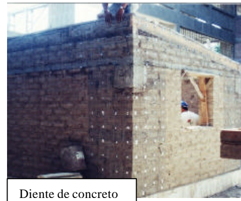
Figura 8. Mejoras estructurales en viviendas nuevas de adobe.
