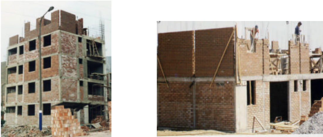
Figura 1. Secuencia constructiva en edificaciones de albañilería confinada
