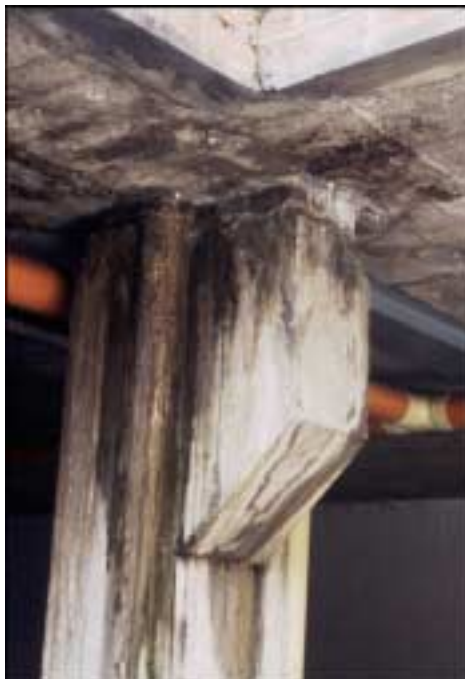
Figura 4 – La inspección preliminar es el primer paso para el mejor tratamiento de las patologías de las edificaciones.
