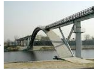
Vista lateral Puente de la Paz
