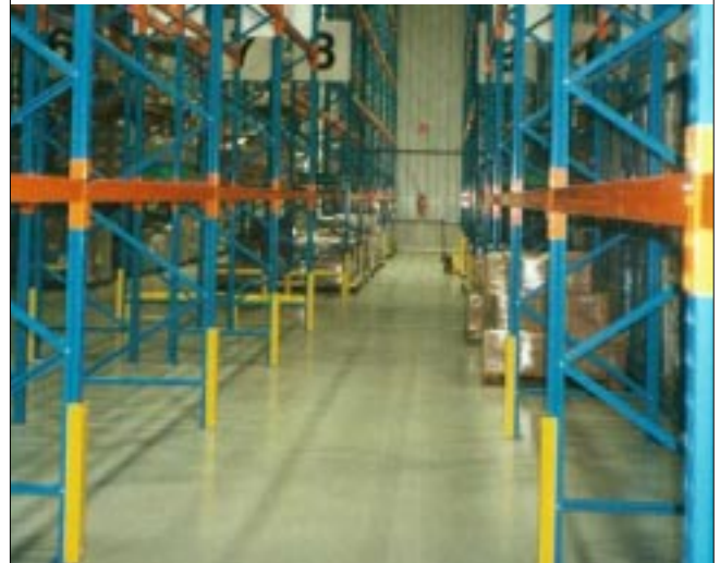
Sin juntas de expansión. Laboratorio Alcón, Argentina, área total = 1.600 m 2
