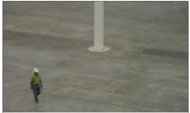
Se observa que las columnas están aisladas de la placa para evitar fisuraciones de piso.
