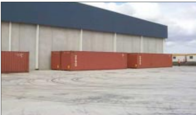
Bodega de almacenamiento de partes para vehículos: Altas cargas, altas prestaciones
