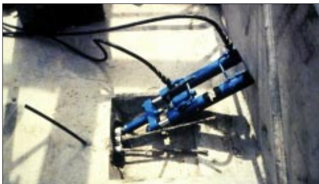
Detalle de tensionamiento de cables
