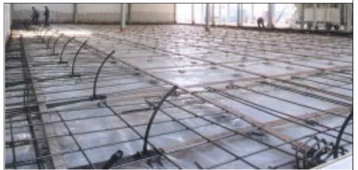
Cables colocados por bandas. Se aprecia un tubo curvo perpendicular a la placa, por el cual se aplica la lechada que permitirá la adherencia entre cables y concreto
