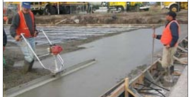
Vibrado del concreto, mediante regla vibratoria
