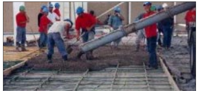
Proceso de fundición similar a los sistemas convencionales. Durante la fundición debe evitarse alterar la distribución de los cables.
