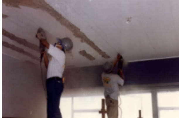
FOTO 04: Preparación previa de la superficie en una losa aligerada. Reforzamiento de losa de sótano en Local de Telefónica del Perú en Surquillo.
