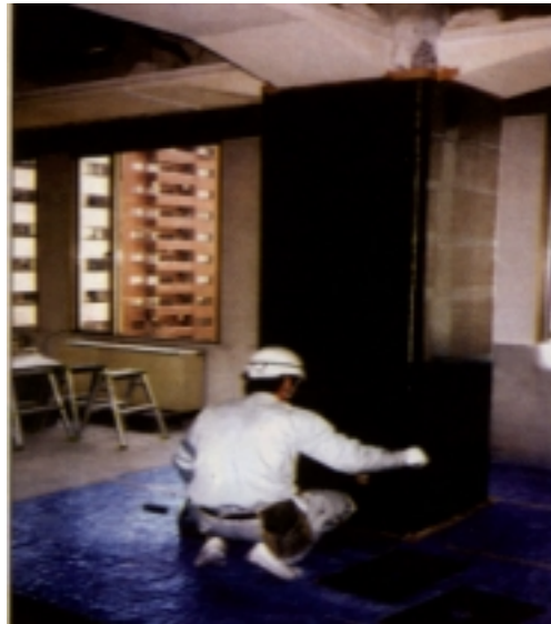
Foto 01: Reforzamiento de columnas con tecnología de punta: Sistema FRP.
