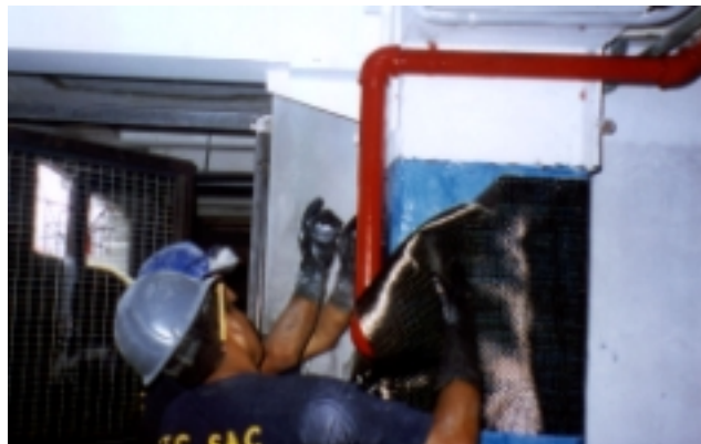
FOTO 03: Preciso instante de colocación de la fibra sobre el saturante, en una columna. Local de Plaza Vea Higuiereta - Surco
