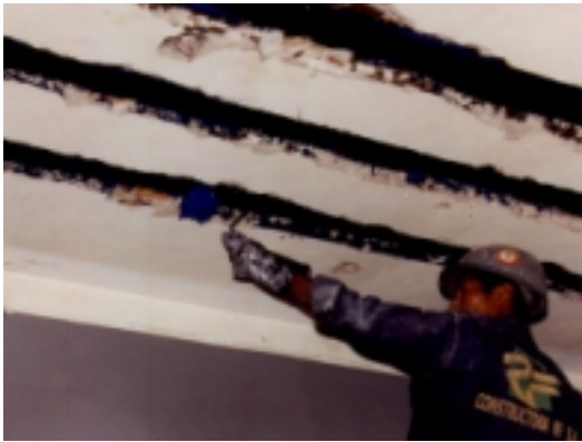
FOTO 04: Preparación previa de la superficie en una losa aligerada. Reforzamiento de losa de sótano en Local de Telefónica del Perú en Surquillo.
